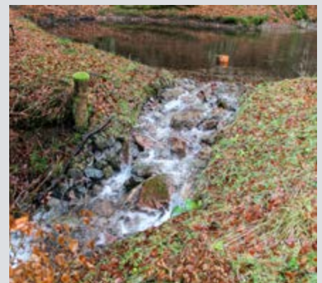
Flachgewässer mit sohlgleitenartigem Überlauf
