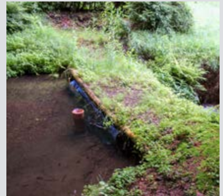
Teich mit Durchlass vor Umbau
