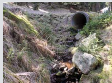
Sohlabschlag am Auslauf eines Durchlasses
