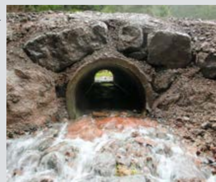
Durchgehendes Interstitial nach Sohlanhebung
