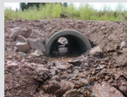
Rohrdurchlass nach Umbau mit durchgehendem Interstitial
