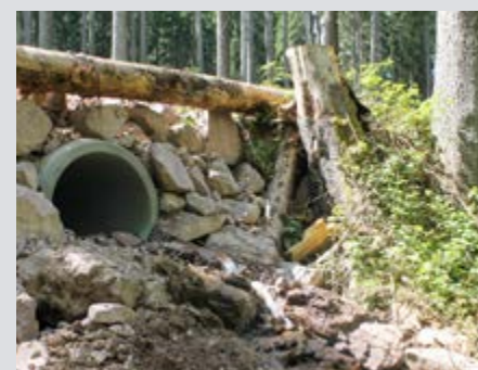
Rohrdurchlass nach Umbau mit anschließender Sohlgleite
