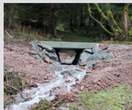
Überfahrt nach Umbau
