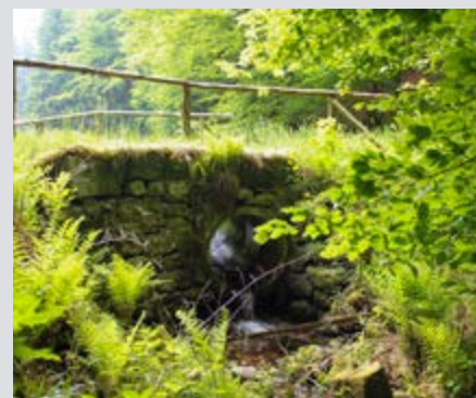
Rohrdurchlass vor Umbau (Titelbild nach Umbau)
