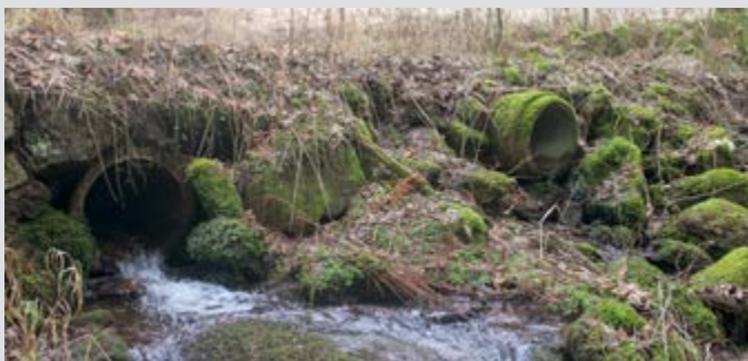
Vor Umbau: enger Rohrdurchlass mit Sohlabsturz
