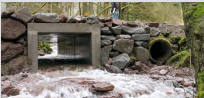
Nach Umbau: weiter Rechteckdurchlass mit durchgehender Bachsohle
