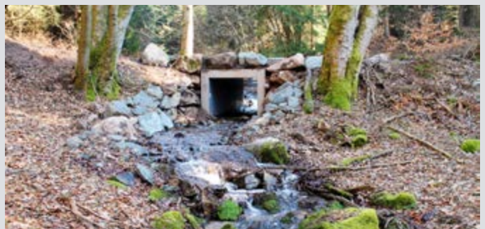
Nach Umbau: Rechteckdurchlass mit reduzierter Verklausungsgefahr
