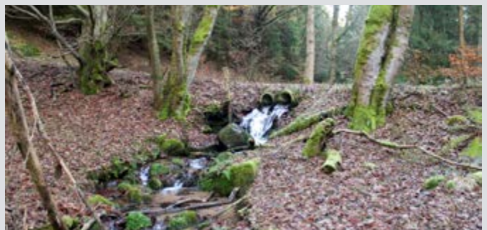
Vor Umbau: Doppeldurchlass (verklausungsgefährdet) mit Sohlabsturz
