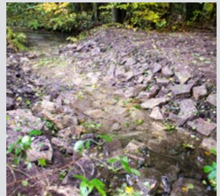
Bachbett nach Rückbau der Überfahrt
