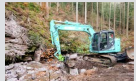
Nach der Sprengung werden die Betonreste geborgen und entsorgt.
