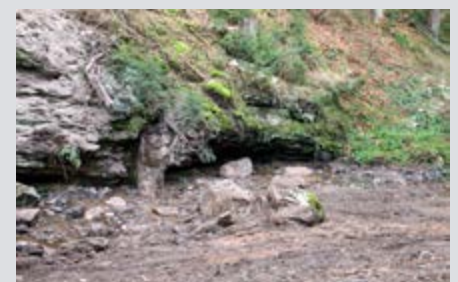
Nach dem Rückbau ist wieder ein naturnahes, frei fließendes Gewässerbett vorhanden.
