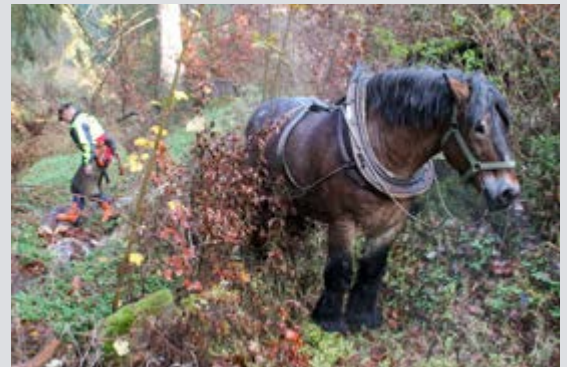
Rückepferd beim Totholzeinbau in einem Waldbach: Naturnahe Bachauen sind mit schwerem Forstgerät nicht gut erreichbar. Die traditionelle Arbeit mit einem Pferd ist hier besser geeignet.
