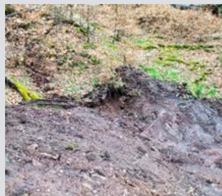
Der Quellbereich nach Entfernung der Beton-einbauten
