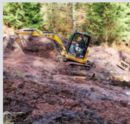
Die notwendigen Arbeiten vor Ort wurden mit einem Kleinbagger ausgeführt.
