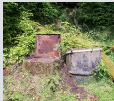
Blick auf die Quellfassungen vor dem Abriss
