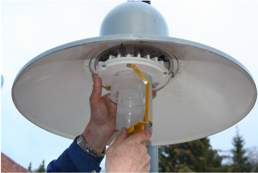
Umrüstung von Straßenbeleuchtung auf klimafreundliche LED-Technologie; © Naturstiftung David, Foto: Matthias Golle
