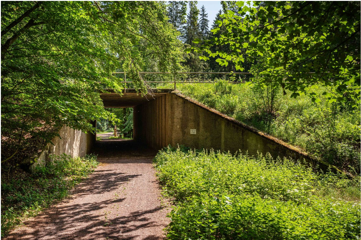
Betonbauwerk Schanzenauslauf „Walter Ulbricht Schanze“, Foto: Thomas Müller (07/2023)
