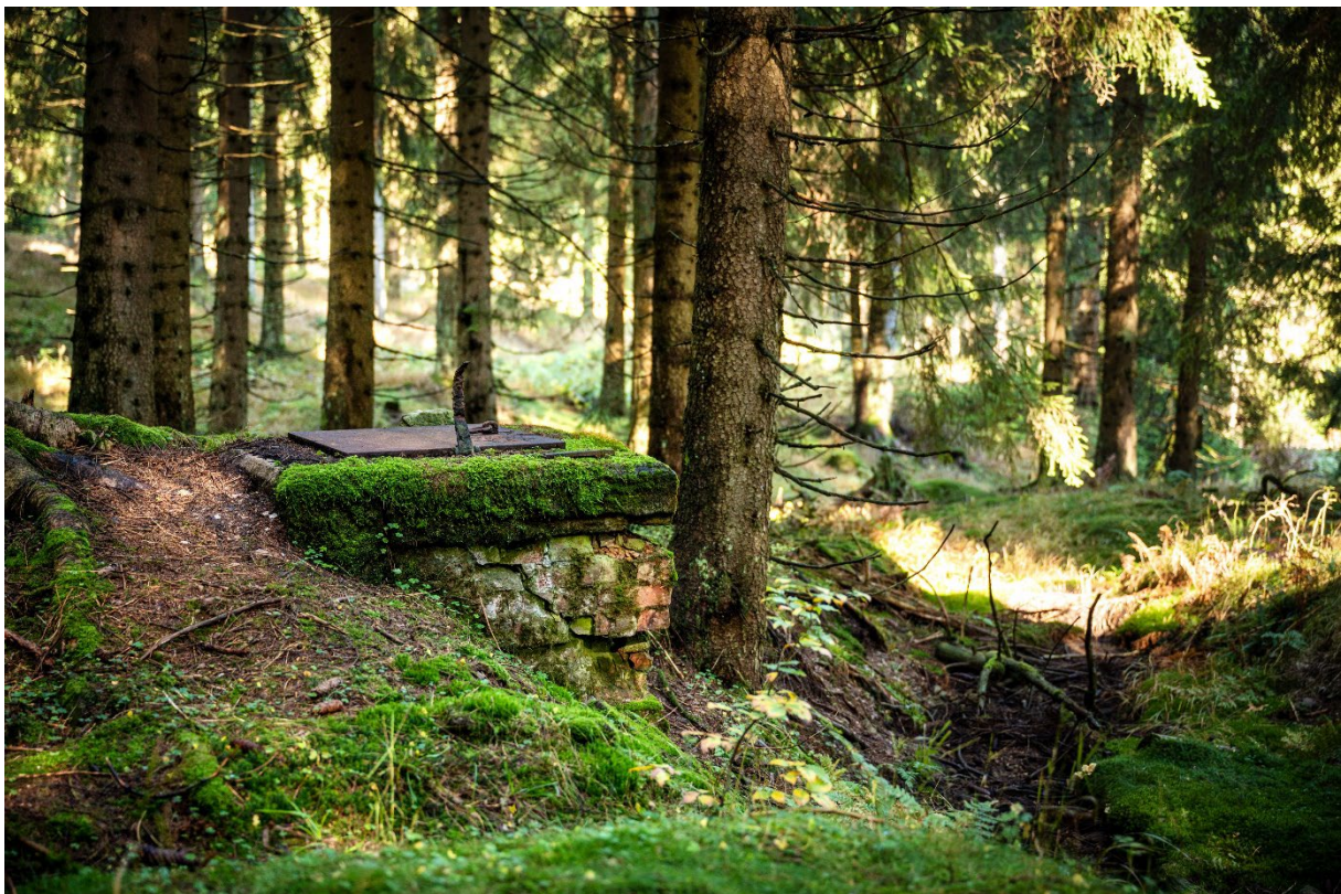
Brunnenschacht und oberirdischer Entwässerungsgraben am Schmücker Graben, Foto: Thomas Müller (10/2022)
