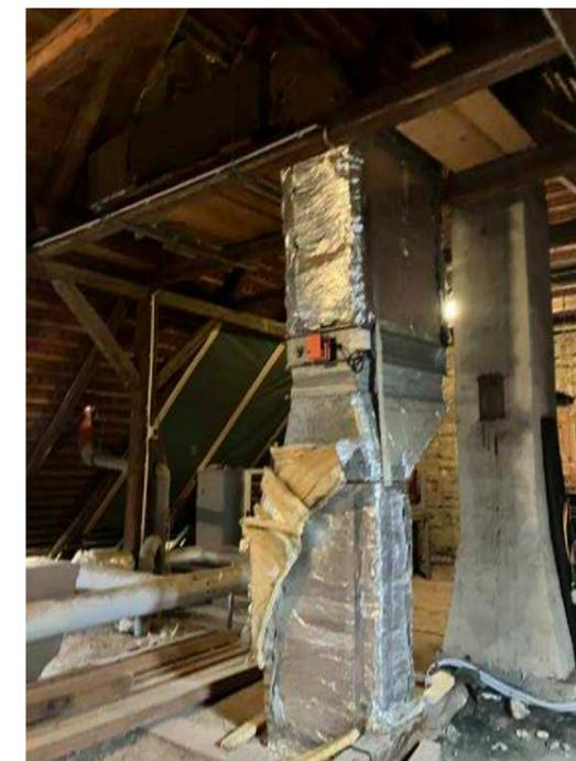
Abbildung 3: Küchenabluft über Dach ohne Wärmerückgewinnung
