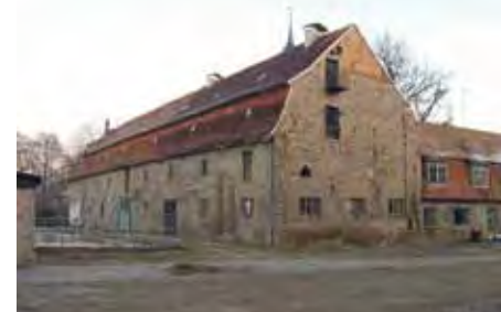
Große Vorhaben wollen gründlich bedacht sein: Für Sanierung und Nutzung des Rittergutes Ostramondra entsteht eine Machbarkeitsstudie, die aus Mitteln der Regionalentwicklung gefördert wird.
